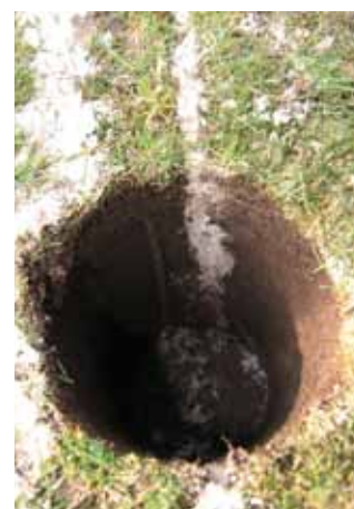
Green po provedení ošetření strojem Sand-Master prořezání do hloubky až 20 cm a vyplnění drážky pískem.
